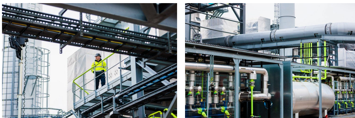
Figuur 3 – ingebruikname fabriek (januari 2026)
