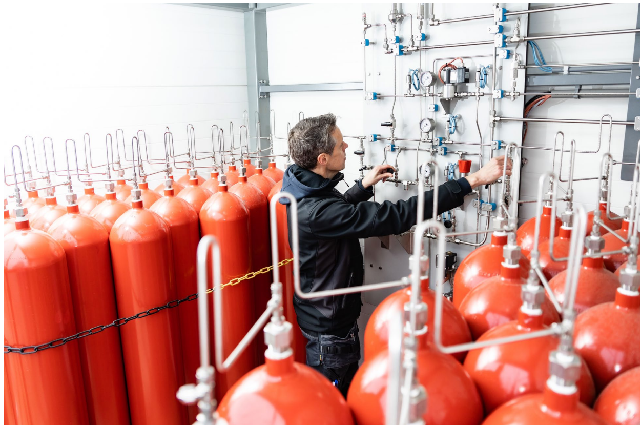
Afbeelding: Joel Bosrup (Wintersol) aan het werk bij het regelpaneel van de waterstofbuffer (foto Jurriaan Huting)
