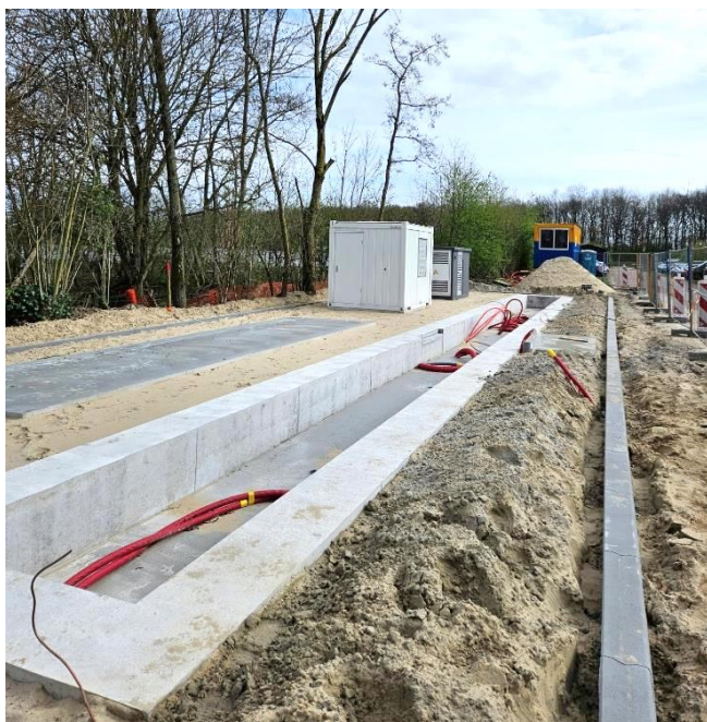
36 Van links naar rechts: realisatie van het fundament t.b.v. de elektrolyser installatie, realisatie van de waterstofleiding van de elektrolyser naar het tankstation, en levering van de elektrolyser installatie per kraan in mei 2024
