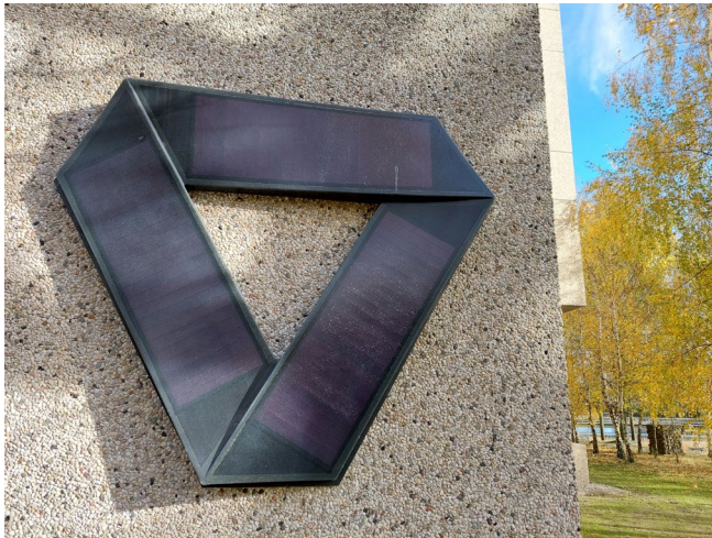
Figuur 8: Dummy paneel aan de westgevel van HTC 5.
