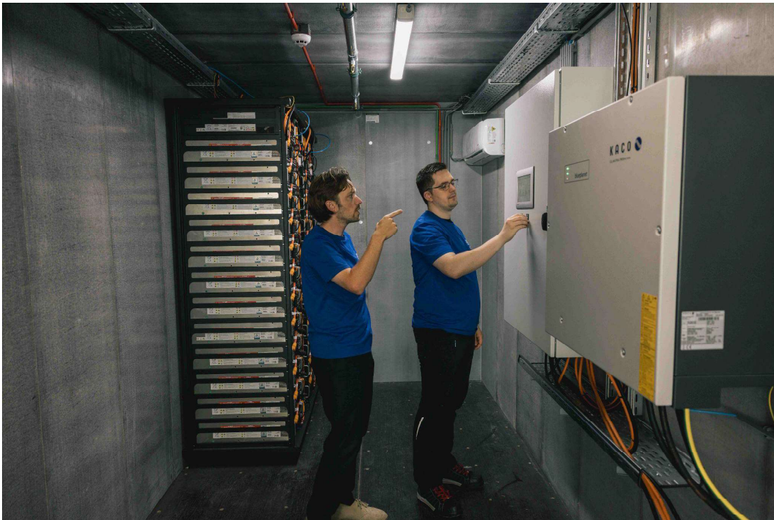
Afbeelding 1. Binnen in de container van Houten, met linksachterin de twee batterijstacks en het AC gedeelte. Zoals is te zien is er voldoende ruimte voor uitbreiding.
