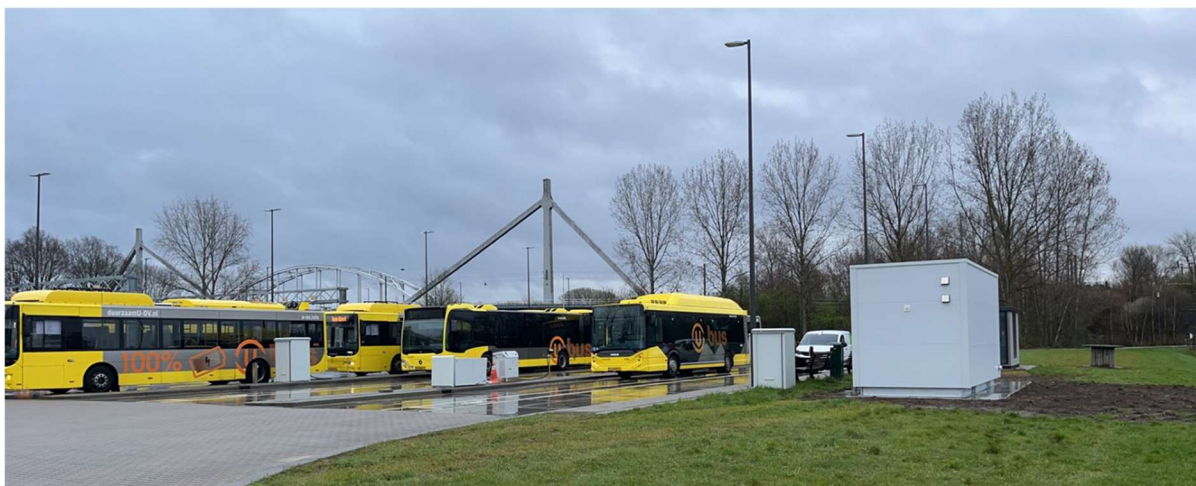
Figuur 23: Refurbished batterij op laadremise voor e-bussen van Qbuzz in Utrecht.
