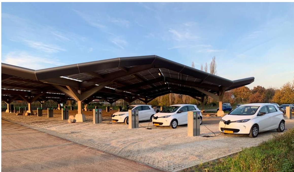
Figuur 22: Het bidirectionele laadplein met overkapping met zonnepanelen bij het hoofdkantoor van de Triodos Bank.
