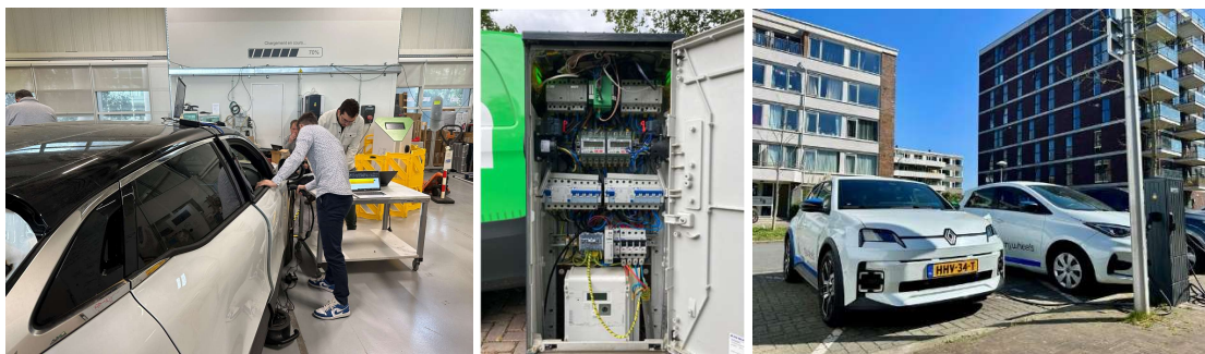
Figuur 7 In april 2025 zijn de eerste V2G Renault 5 deelauto's geplaatst door We Drive Solar en MyWheels in Utrecht. Links: testen van de nieuwe WDS-laadpaalcontroller bij het Renault Technocentre in Parijs; midden: vervanging van de controllers in de laadpalen door nieuwe versie die de nieuwe protocollen ondersteunt; rechts: eerste Renault 5 ingezet als MyWheels deelauto op V2G laadpaal. V2G-bedrijf zal starten in mei 2025.
