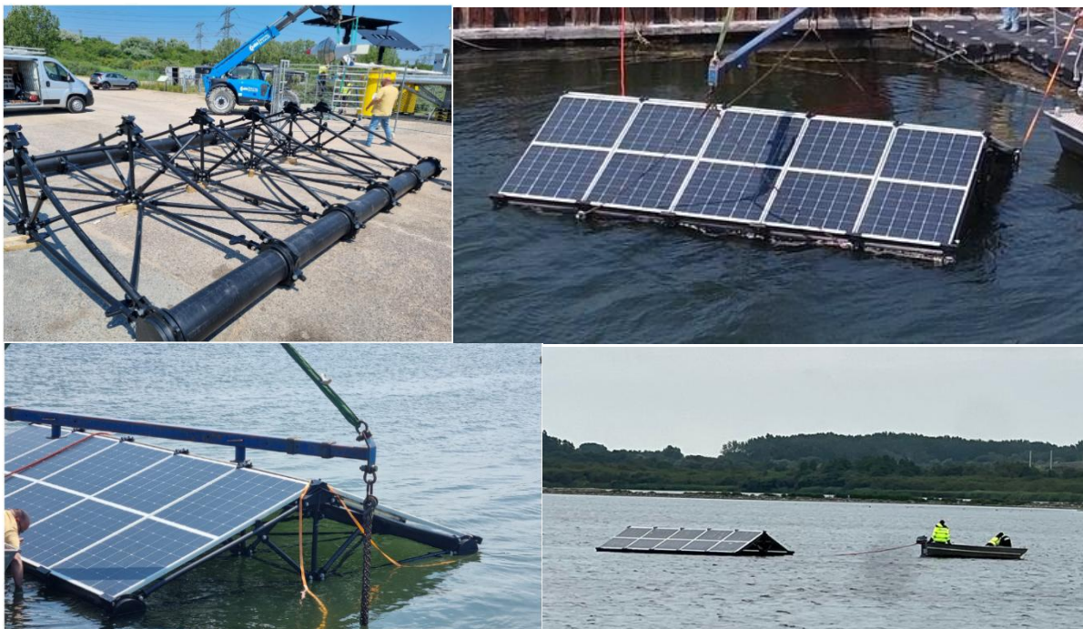
Figure 2: Assemblage op het Fieldlab, tewaterlating en het verplaatsen naar de ankerlocatie.
