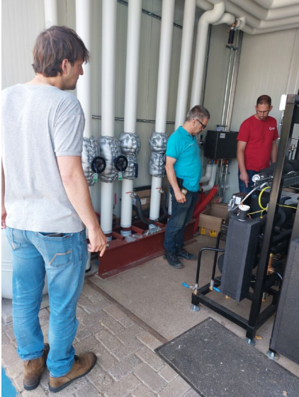
Foto: werkzaamheden aan het warmtenet door vertegenwoordigers van TU Delft, NetVerder en DEP
