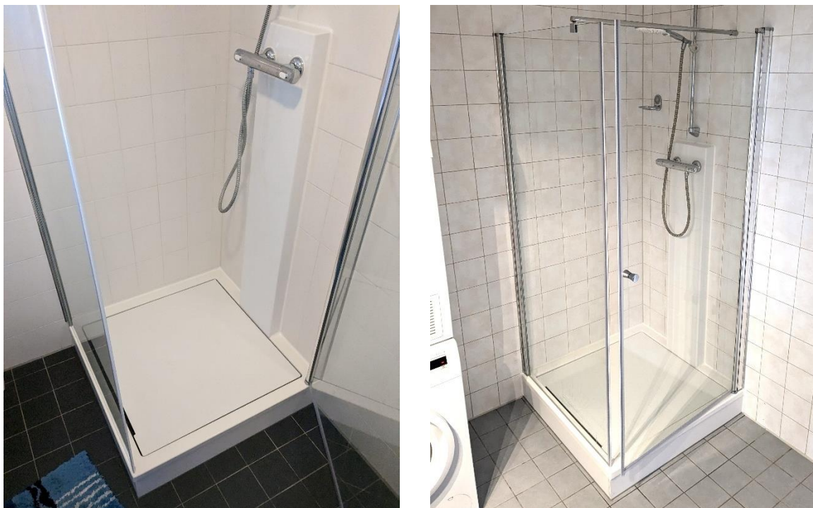
Figuur 10 – Geïnstalleerde X-Trays in huurwoningen van de Alliantie
