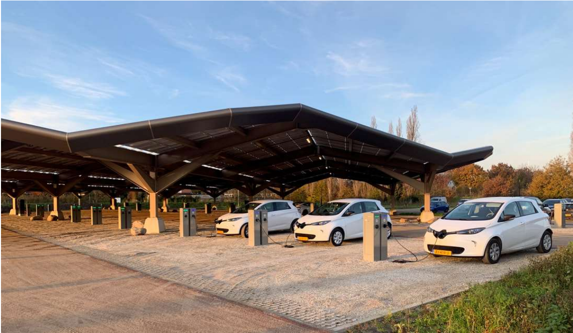
Figuur 15: Het bidirectionele laadplein met overkapping met zonnepanelen bij het hoofdkantoor van de Triodos Bank.
