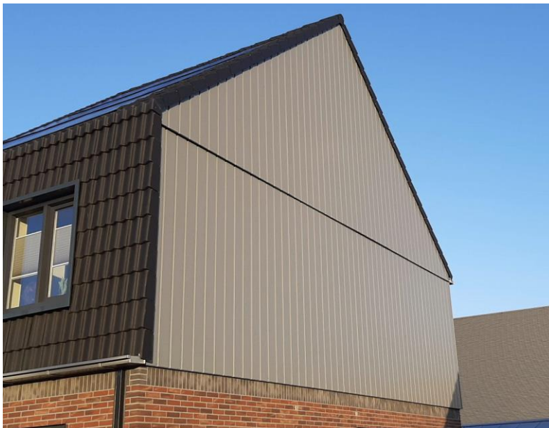
Testopstelling geveloplossing op een woning op het terrein van Emergo
