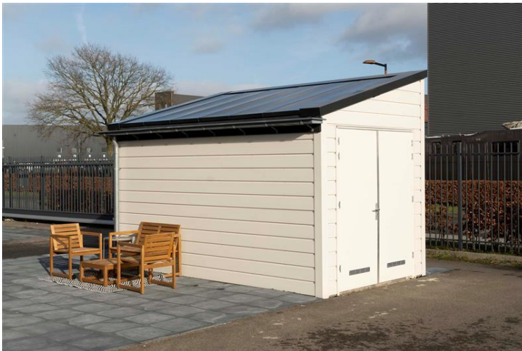
Testopstelling Energieberging op het terrein van Emergo met warmtewindak en -gevel en prefab ingebouwde installaties met een combiwarmtepomp en warmtebuffer.
