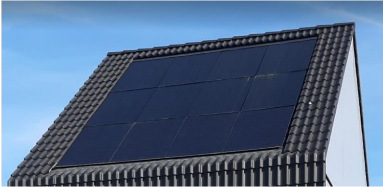
Testopstelling dakoplossing op een woning op het terrein van Emergo met 8 warmtewinpanelen (ST, bovenste 2 rijen) en 4 warmte- en stroomwinnende panelen (PVT, onderste rij).
