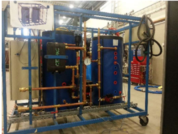
Figuur 76 Test opstelling bij TNO
