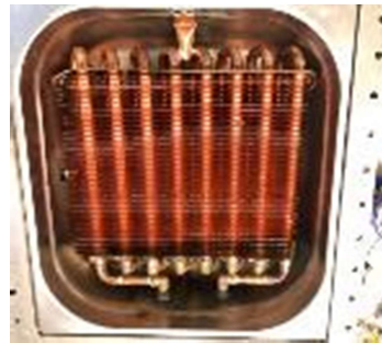
Figuur 8 Warmtewisselaar aangebracht
