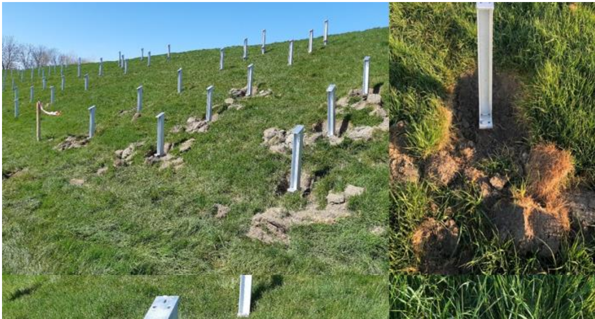
Figuur 8 Foto na het plaatsen van de palen van het TNO-Eurorail systeem, waarbij graszoden gedeeltelijk zijn uitgedroogd.
