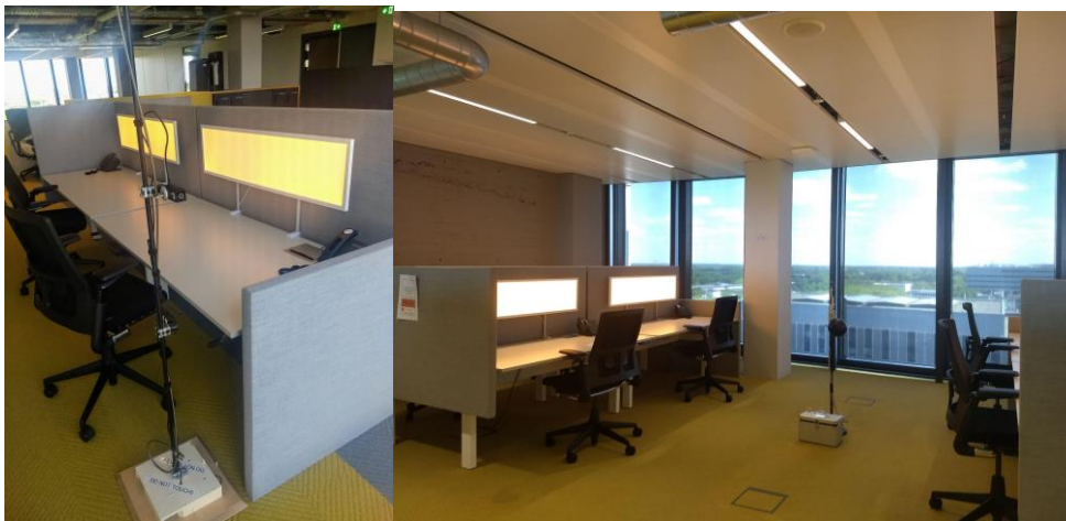
Figuur 26 Hue Aurelle armaturen zoals gebruikt in de Atlas veldstudie
