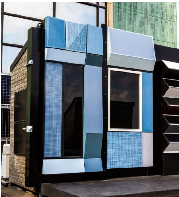
Figuur 2: Het ontwerp is gebaseerd op 2 typen Prefab bouwsystemen; een aluminium gevelsysteem (links) en een houten gevelsysteem (rechts). Vervolgens zijn er diverse PV-gevelelementen toegevoegd: kristallijn PV panelen met gekleurd glas (linksonder) en gekleurde folie (rechtsonder), composiet cassetes met geïntegreerde kristallijn PV panelen (midden) en composiet elementen met geïntegreerde PV-folie.(linksboven)
