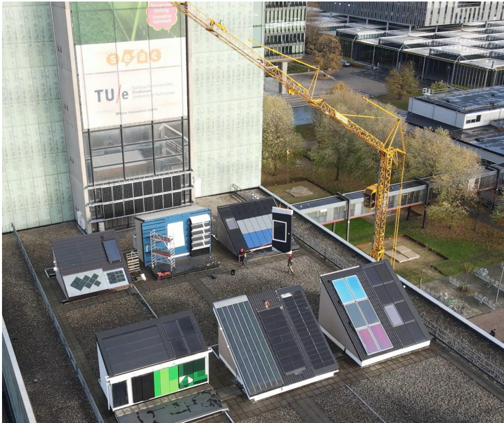
Figuur 6: Installatie van het hsb-element met geïntegreerd PV-raam
