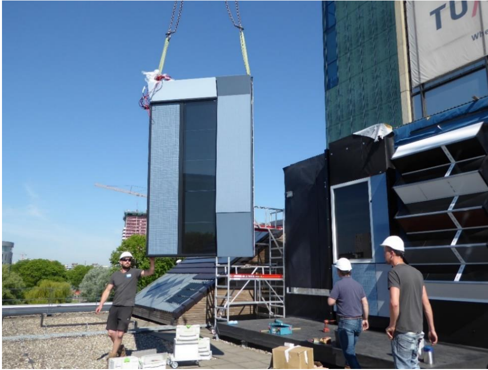
Figuur 8: Installatie van het prefab gevelement
