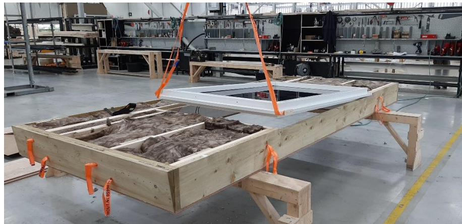
Figuur 4: Hsb element tijdens productie en montage van PV-raam
