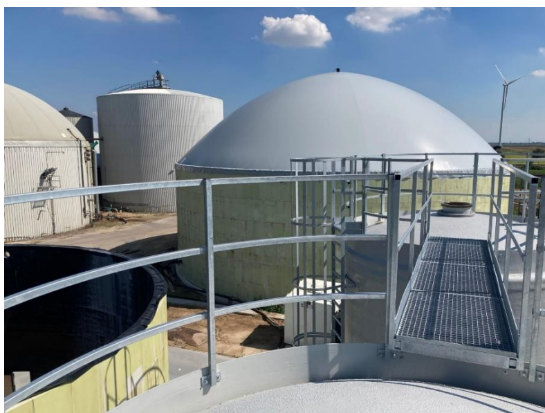
Figuur 3: Dubbelmembraandak anaerobe gisting
