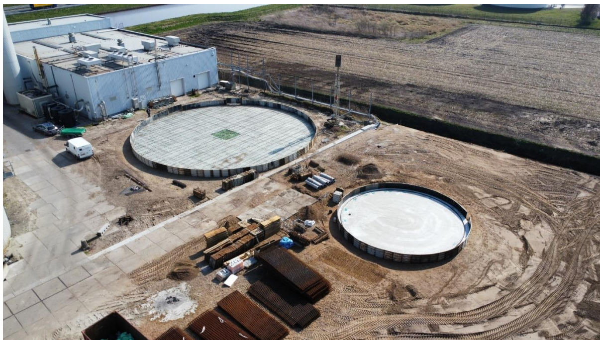
Figuur 2: Vloeren betonnen tanks hydrolyse reactor en gisting
