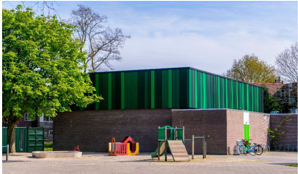
Figuur 3 Gymzaal de Vrijmark Almere, na installatie van de FITS-panelen.
