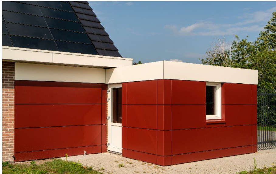
Figuur 4 Woning Industriestraat 18, Stadskanaal, na installatie van de FITS-panelen.
