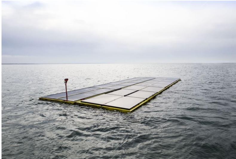
Figuur 5: Foto van de eerste drijvers geïnstalleerd op de Noordzee, November 2019.
