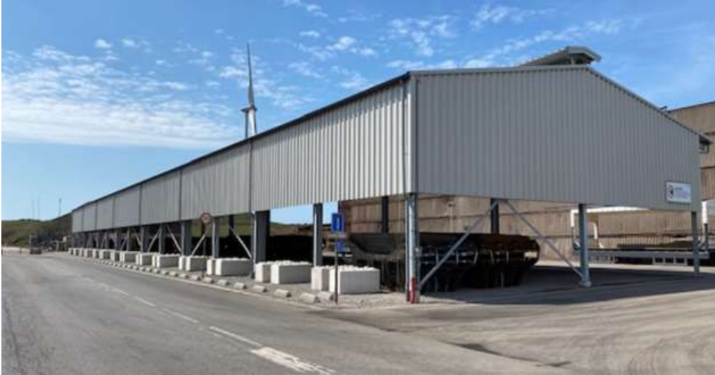
Figuur 7: Koelgebouw (cooling down area)
