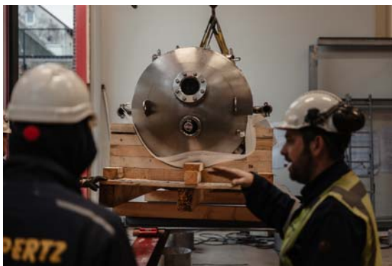
Foto 2 en 3. De nieuwe stripper en ketel die vraag naar stoom sterk verlagen
