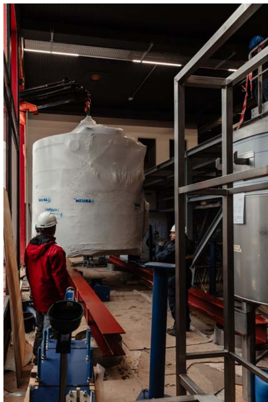
Foto 2 en 3. De nieuwe stripper en ketel die vraag naar stoom sterk verlagen
