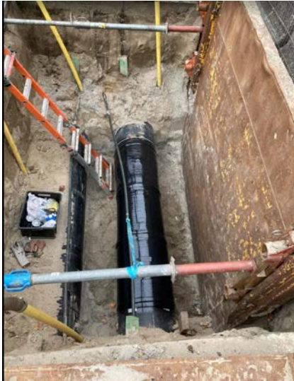
Figuur 9: Voorbeeld van herstelwerkzaamheden aan de warmteleidingen
