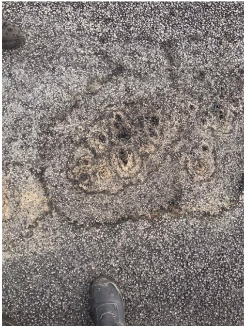
Figuur 8 Foto van het asfalt gelegd in het proefvak van Groningen Seaports met gevlekte textuur.
