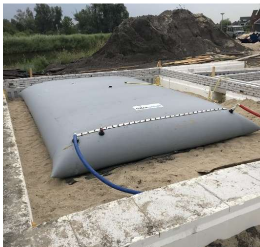
Figuur 2: Buffer aangebracht vóór het plaatsen van de begane grondvloer van een nieuwbouwwoning.
