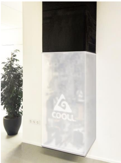
Figuur 3. Functioneel model 1 van de warmtepomp, incl dakdoorvoer. Deze heeft het Cooll pand de afgelopen twee winters verwarmd.
