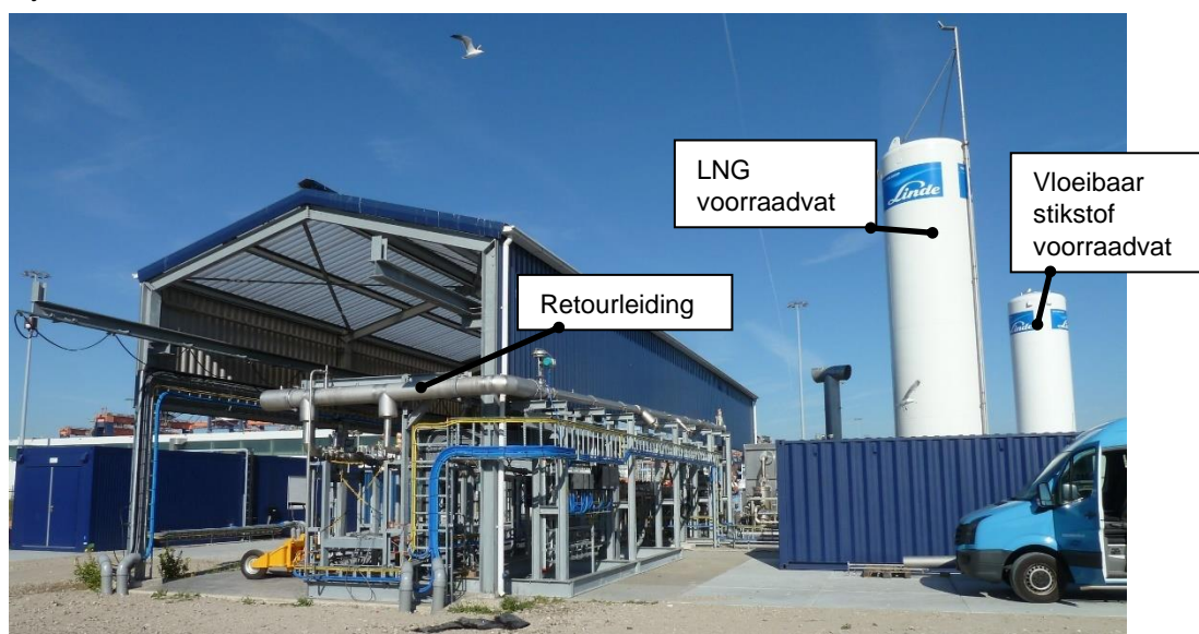
Figuur 1: VSL's LNG kalibratie- en testfaciliteit voor flow- en kwaliteitsmetingen (achterzijde). Foto uit [5].
