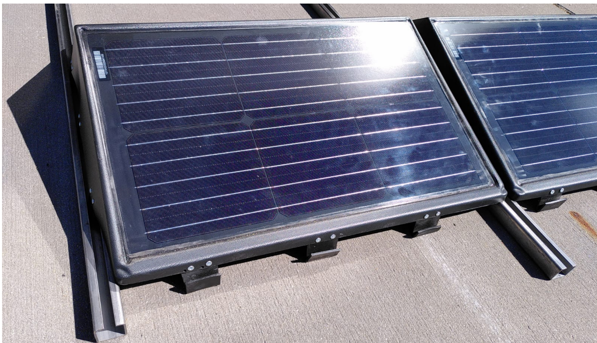
Afbeelding 4: prototype van een 'kliksysteem' voor de CS55 modules.
