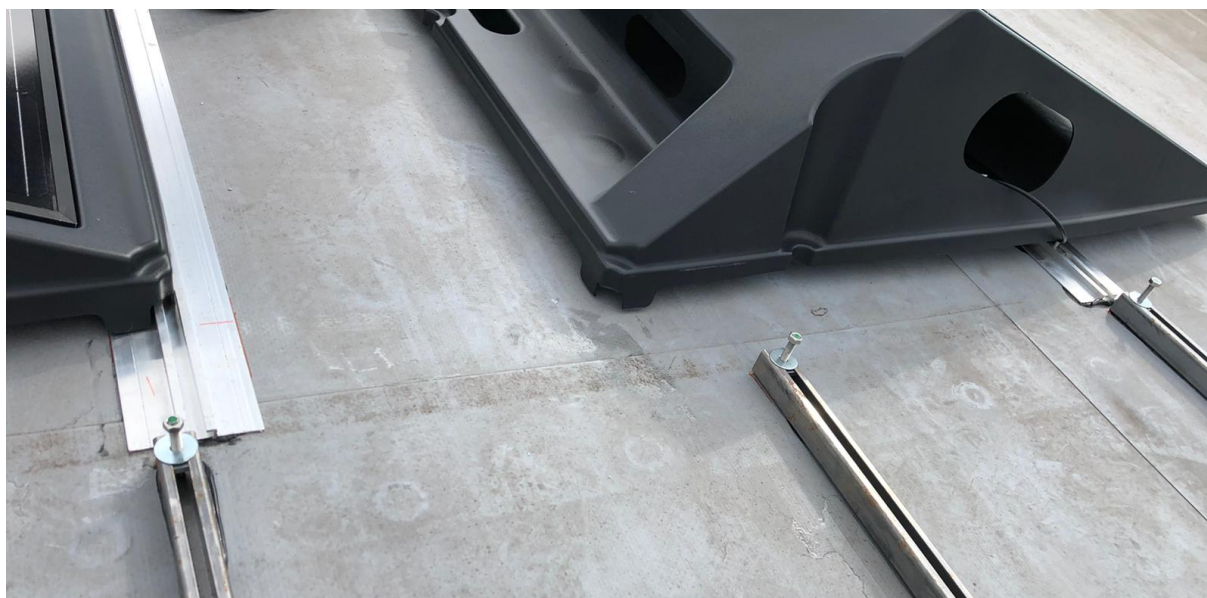
Afbeelding 16: onderzoek naar de toepassing van verschillende nieuwe vormen van onderconstructie op PVC dakbedekking.
