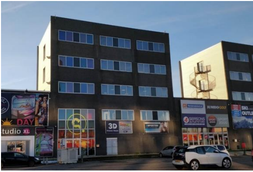
Figuur 7. Overzichtsfoto van het gebouw van Qeske. Op de tweede verdieping zijn de metingen verricht..
