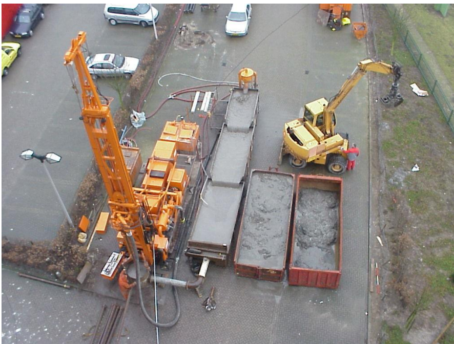
Figuur II-1: Boorstelling zuigboren
