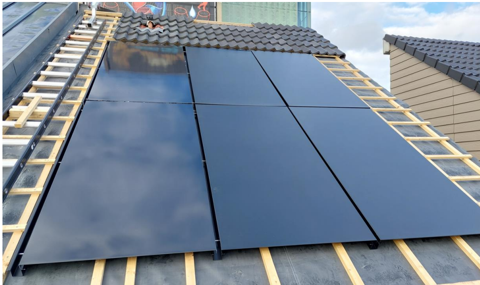
Figuur 5: Nieuwe IWP-schuindak collectoren (3 stuks) en dummy-platen (3 stuks) gemonteerd op Cabin 5 van SolarBEAT. Aannemer zal binnenkort de zijkant afwerking met gewone dakpannen uitvoeren. Dit is puur esthetisch. Het systeem zoals nu op de foto te zien, is al waterdicht.
