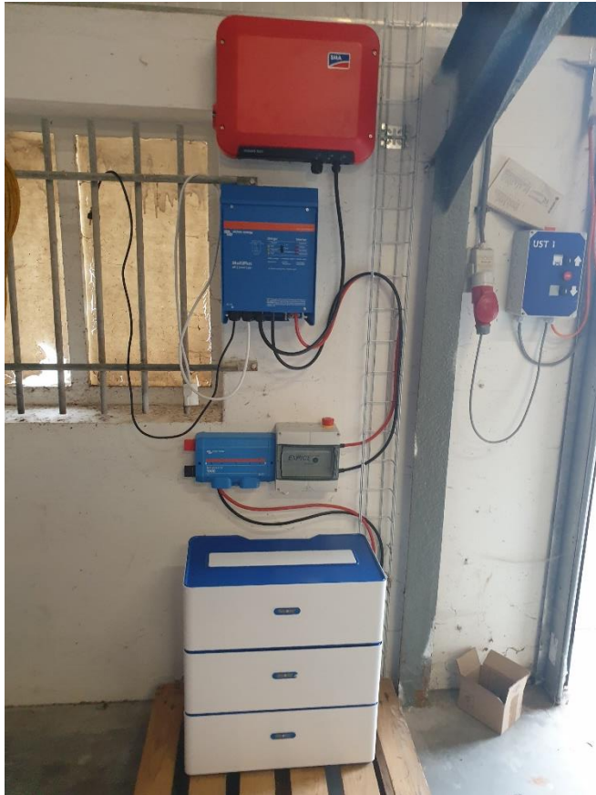
Figuur 6: Het BMU zoals geïnstalleerd op de boerderij van DBS in Hoevelaken.
