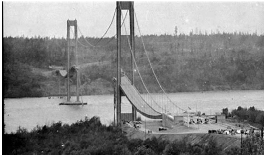
Figuur 1. Foto van de Tacoma Narrows Bridge ("galloping Gertie") genomen tijdens de ineenstorting op 7 november 1940 als gevolg van aero-elastische instabiliteit.
