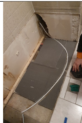
Aanleggen koud water
