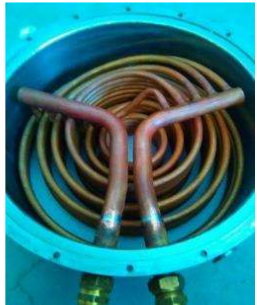
Figuur 8 SWeKOS module - condensor & verdamper
