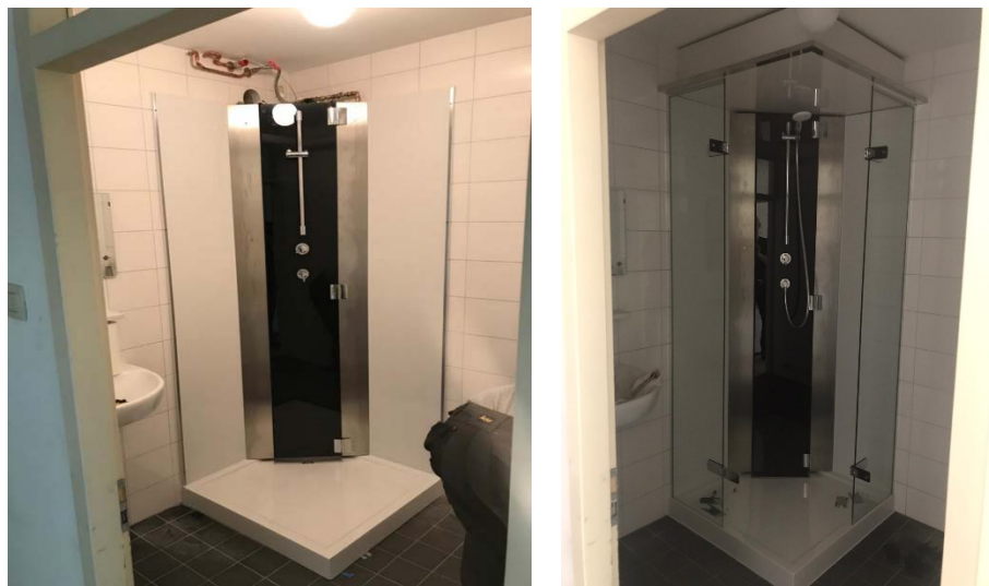
Figuur 8 Vidomes 1, ventilatieafvoer en drinkwateraansluiting boven douchecabine. Op de rechterfoto is de afwerkplint met daarboven een luchtspleet zichtbaar.
