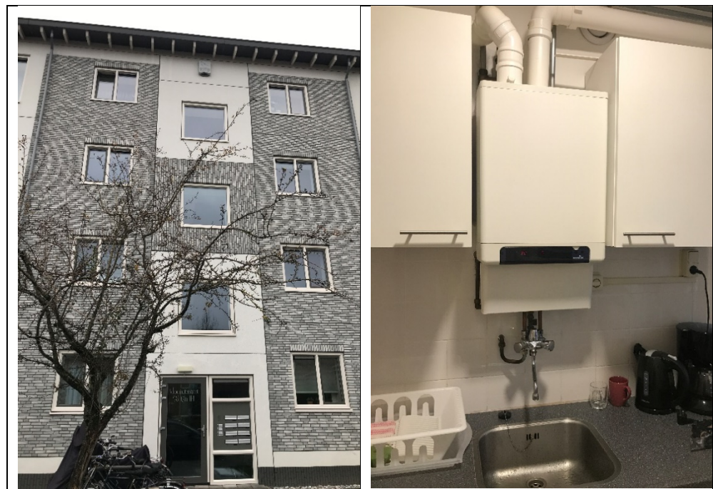
Figuur 4 Portiek flatwoningen in Moerwijk Oost na renovatie: links EPS gevel met steen strips, rechts CV-ketel voor verwarming en warmtapwater.
