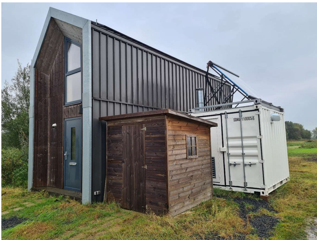
Figuur 6: Demo woning (Tiny House) op Campus Almkerk, met daarop aangesloten de container met daarin de warmtebatterij installatie. Op het dak van de container staat de thermische zonnecollector.
