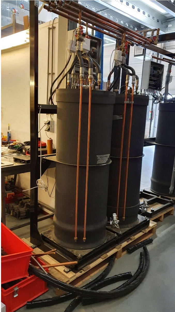
Figuur 1: Skid met twee modules, in aanbouw bij RTB de Beijer in Duiven. De skid bevat één testmodule en één reservemodule.
