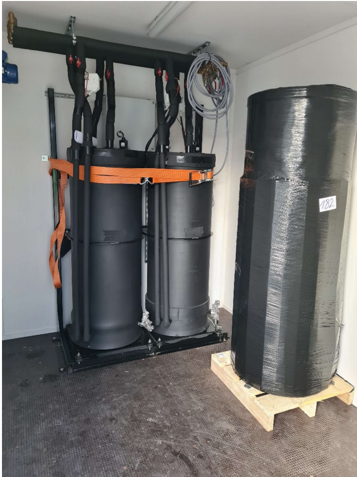
Figuur 3: Demosysteem in de container, gereed voor realisatie. Achterin de skid met de twee TCS modules, rechts de zonneboiler nog in de verpakking.
