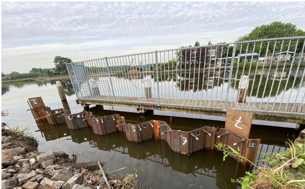
Energie damwanden klaar voor de beproeving, locatie ten zuiden van Delft
