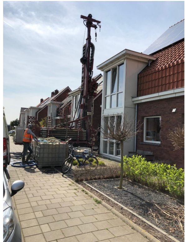
Figuur 8 - Test sonische boormethode
