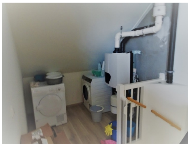
Figuur 5 – Compact plug & play all-electric systeem Oude situatie met cv-ketel (boven) en nieuwe situatie met plug & play combi-warmtepomp en extra buffervat voor vergroting van waterinhoud afgiftesysteem hiernaast.
