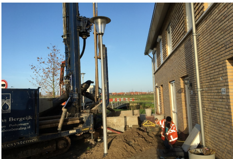
Figuur 4.2 – Installatie van de bodemlus in de openbare ruimte
