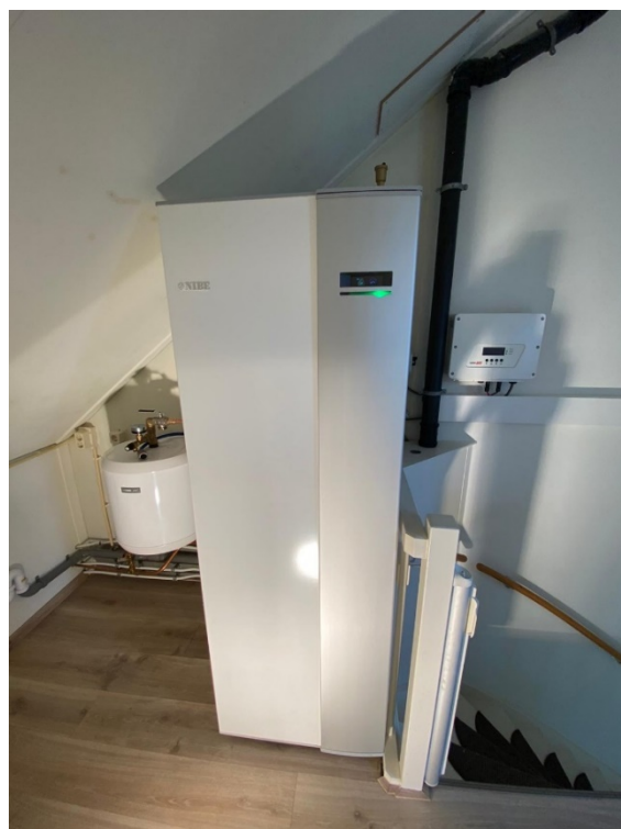
Figuur 5 – Compact plug & play all-electric systeem Oude situatie met cv-ketel (boven) en nieuwe situatie met plug & play combi-warmtepomp en extra buffervat voor vergroting van waterinhoud afgiftesysteem hiernaast.
