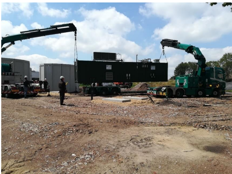
Figuur 2 Het plaatsten van de Bio-Up
