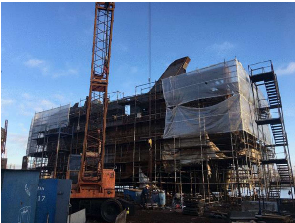
Figuur 2 Bouw van het casco - overzichtsfoto
