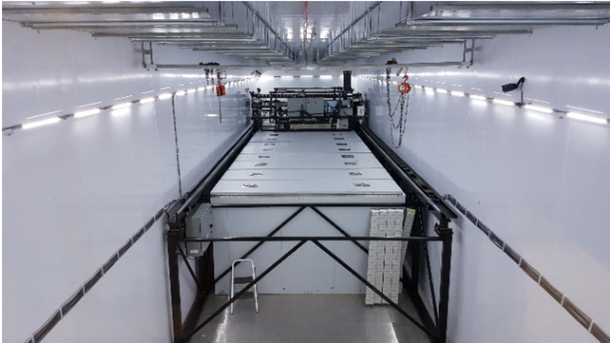
Figuur 8.6 Eén van de twee BiOS-installaties met zes vrieskisten
