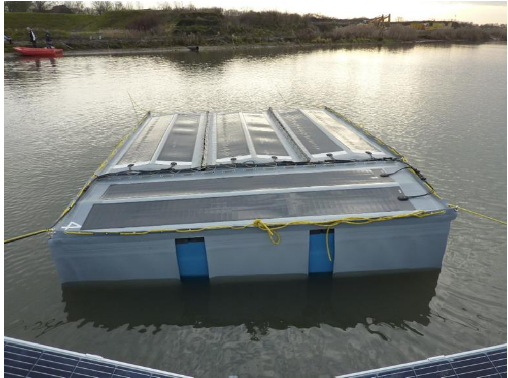
Figuur 2. Demo Weeperpolder bij plaatsing op 19 december 2019. Het schuim van de stabilisator is hier nog niet volgezogen met water. Dit duurt ongeveer een dag.
