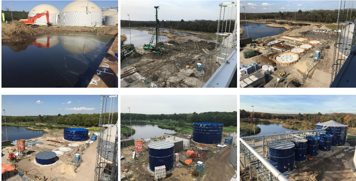
Figuur 1: Foto's realisatie installatie
