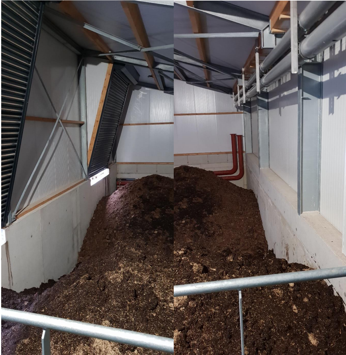
Figuur 11/12 Innamekelder vaste stof (met "walking floor")
