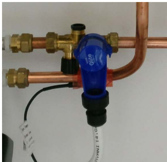
Figuur 1 Sensor op de warm waterleiding omgeven door een stuk isolatieschuim.
