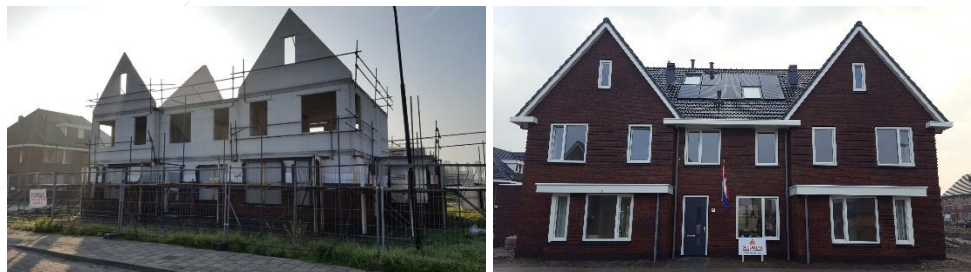
Figuur 8: Stelwerk zolderwanden (augustus 2017) en gerealiseerde NeroZero-proefwoning (maart 2018)
