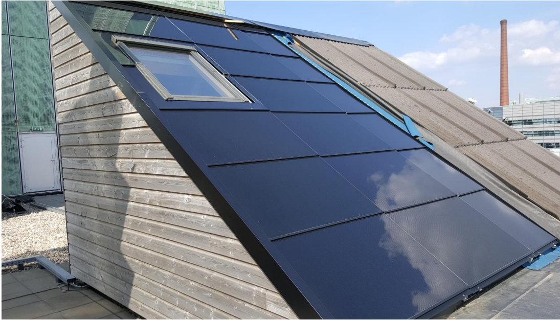
Figuur 4: Prototype ReBor prefab daksysteem met raam geplaatst 'bewust op lastige locatie in dakvlak', omdat in bestaande bouw ramen bijna nooit matchen met PV-paneel afmetingen.
