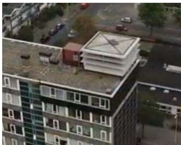
Afb 2: Aanzicht proefwoning (noordzijde) na plaatsing van de nieuwe geveldelen.
