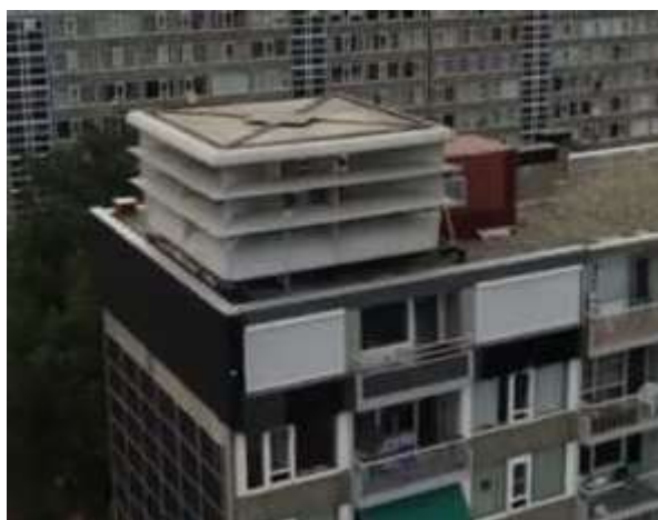
Afb 1: Aanzicht proefwoning (zuidzijde), nog voor plaatsing zonnepanelen in de borstwering van het balkon
