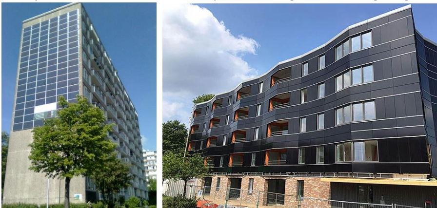
Figuur 1. a) Blauwe zonnepanelen op een bestaande gebouwgevel. b) Geïntegreerde zwarte zonnepanelen in een gevel van nieuwbouw.
