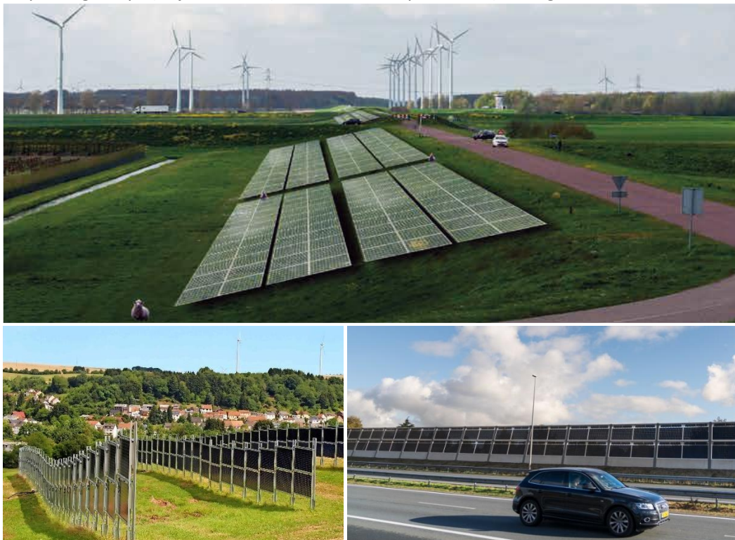
Figuur 2 Voorbeelden van overige toepassingen. a) Artist impression van groene panelen op een dijk [Stowa]. b) Tweezijdige panelen geïntegreerd in een weiland waarbij agrarisch gebruik mogelijk blijft [next2sun]. c) Zonnepanelen als geluidsscherm [Solar Highway].
