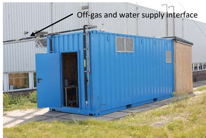
Figuur 1. De container met de 50 kW BoP system, zoals geplaatst bij ECNpoTNO in Petten. De interface met de ultra puur watertoevoer, elektrische bekabeling en afgasbuizen met de ECN poTNO site is zichtbaar.
