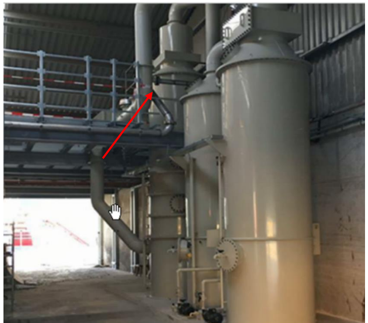
Afbeelding 2: Ammoniakstripper, voorwasser en hoofdwasser (van links naar rechts). Hete lucht vanaf de droger (niet op foto) wordt ingenomen bij rode pijl →
