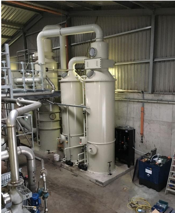
← Afbeelding 3: Opstelling met zuurdoseerkast en tijdelijke IBC's. Hiermee is gedraaid, tot vergunning voor grote opslag kwam. Zie afbeelding 4 ↓
